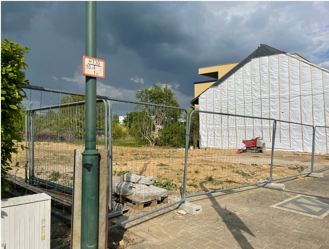
Photo 1: Vue sur la zone du PAP en direction du nord-est
