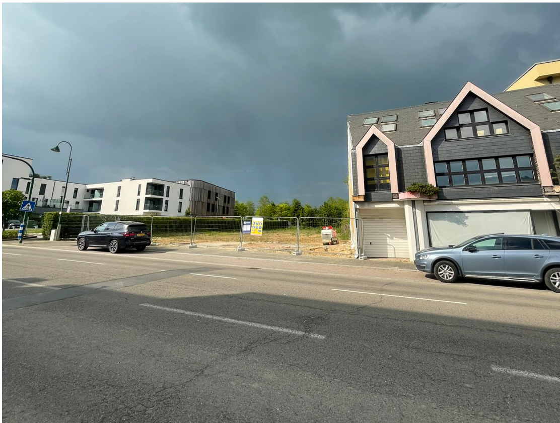
Photo 6: Vue sur la zone du PAP en direction du nord-ouest
